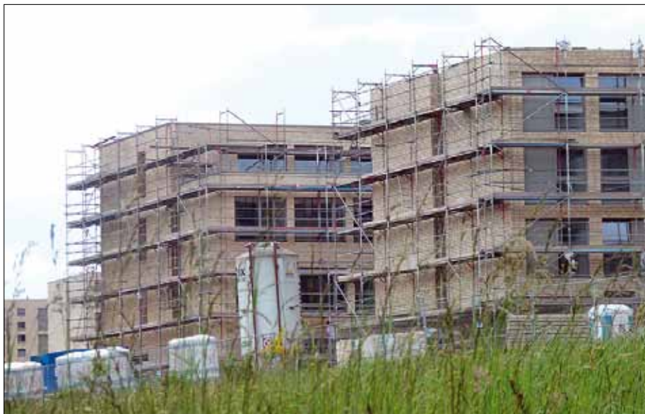
Bereits im August 2014 sollen die neuen Räumlichkeiten der Schule bezugsfertig sein.
